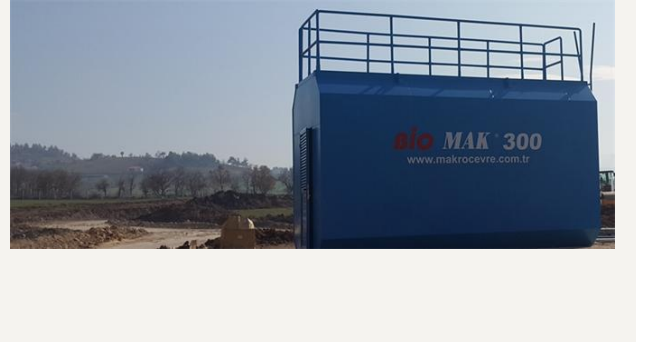
Paket Evsel Atıksu Arıtma Tesisi
